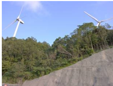
写真は由良風力発電所の風車
